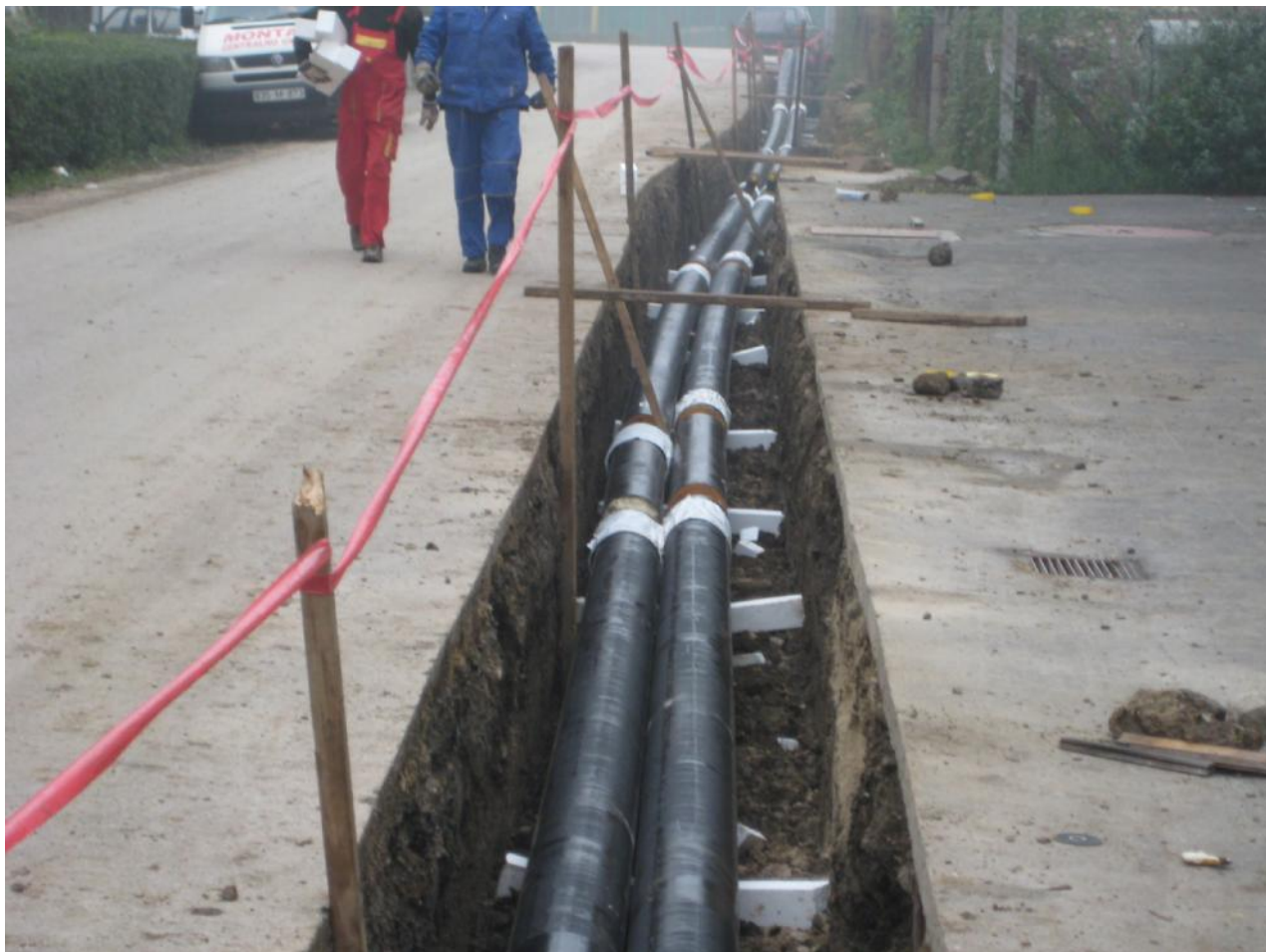
Slika 2. Predizolovani cijevni toplovod
